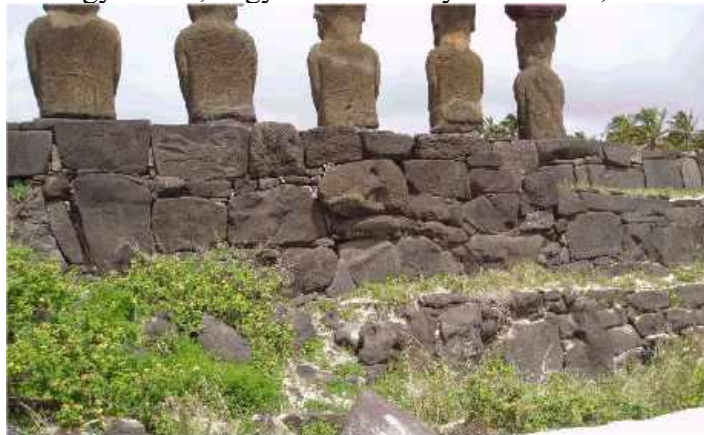
6.10 ábra Ahu Nau Nau tengervédő fala az építkezés legalább hat fázisát mutatja. Figyeljük meg egy moai-fej beépítését.
