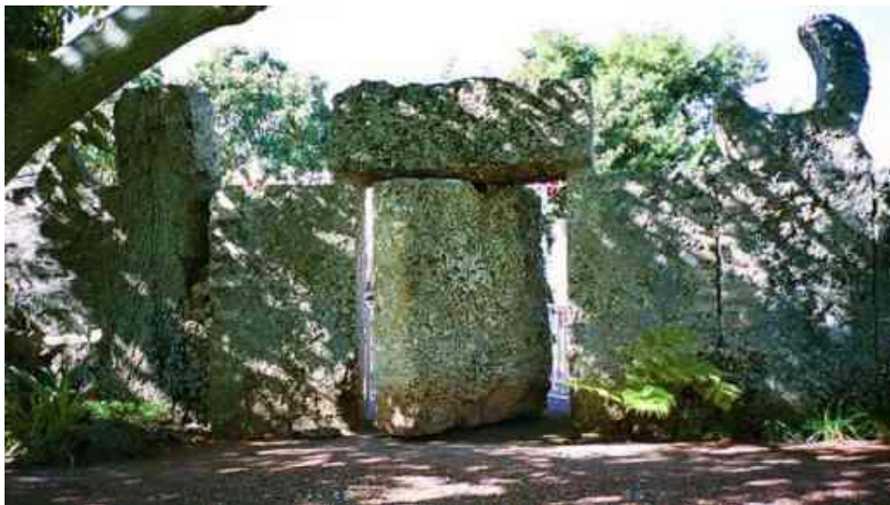
4.6 ábra A 9 tonnás kapu a Korall Kastélyban. Eredetileg forgóajtóként működött, a 2.5 m magas kapu tökéletesen van beállítva és kiegyensúlyozva, és így egy gyerek is ki tudja nyitni egy ujjal megnyomva. 104
