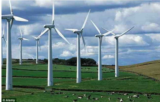
Szélturbina farm, Ingbirchworth, West Yorkshire.
